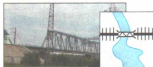
Металлический мост. Насыпь
